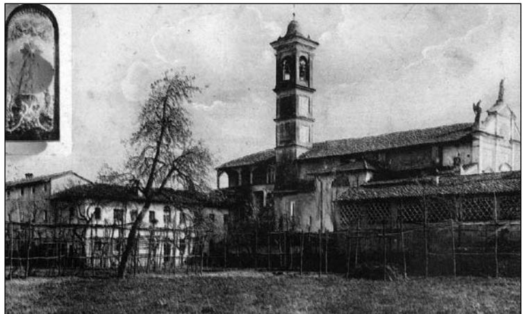
Il convento ampliato e modificato nei secoli. (Foto 1925)
